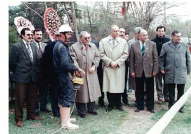
TSKGV'nin Yeni Binasının Temel Atma Töreni, 1996
