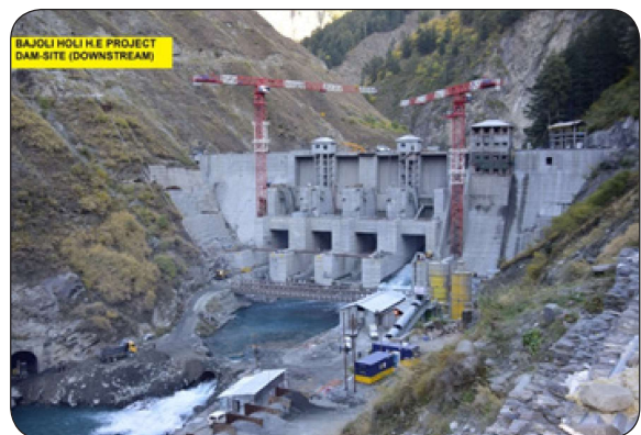
Bajoli Holi Hydro Project
